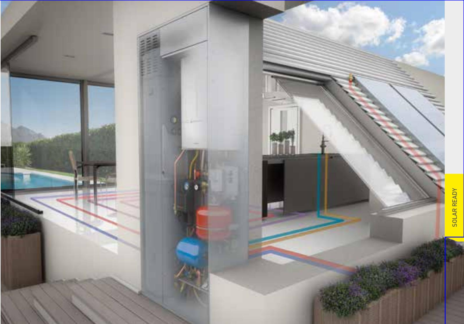
Le soluzioni Solar Ready, ovvero **sistemi integrati con caldaia a condensazione e circuito solare per acqua calda sanitaria**, permettono di ottenere il massimo comfort ottimizzando i rendimenti e riducendo al minimo i consumi di gas.
